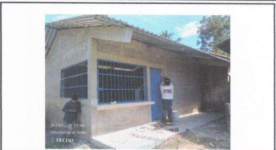
Foto 2: Reparación y cernido de pared.
