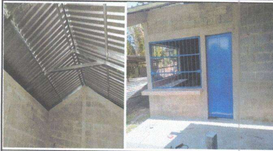
Foto 7: Sustitución de Lamina Por lamina troquelada aluzinc calibre 26
