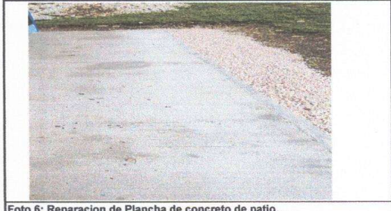
Foto 6: Reparación de Plancha de concreto de patio.
