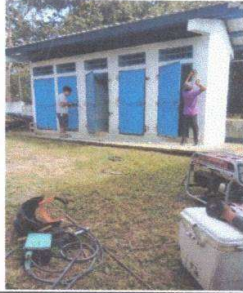
Foto 1: Sustrucción de Puerta de metal.
