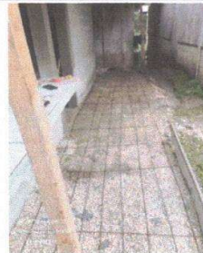
Foto 6: Reparación de Plancha de concreto de patio.
