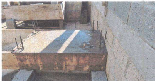
Foto 5: Sustrucción de estufa rural.
