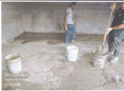
Foto 3: Reparación de Piso de torta de concreto.
