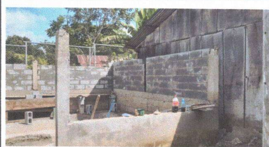
Foto 2: Reparación y cernido de pared.
