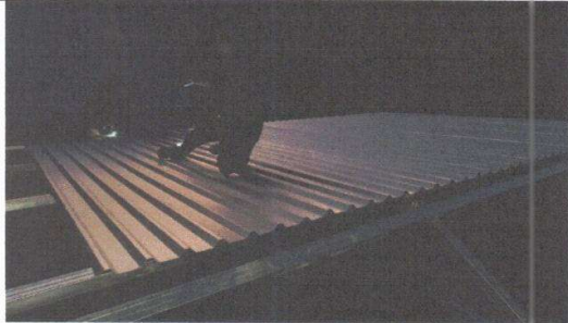
Foto 7: Sustitucion de Lamina Por lamina troquelada aluzinc calibre 26
