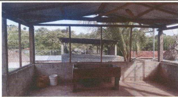
Foto 5: Sustitución de estufa rural
