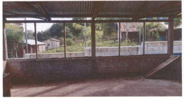
Foto 2: Reparación y Cernido de pared.
