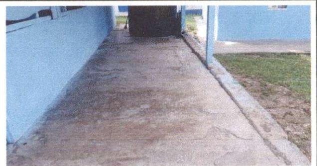
Foto 6: Reparación de planchas de concreto de patto
