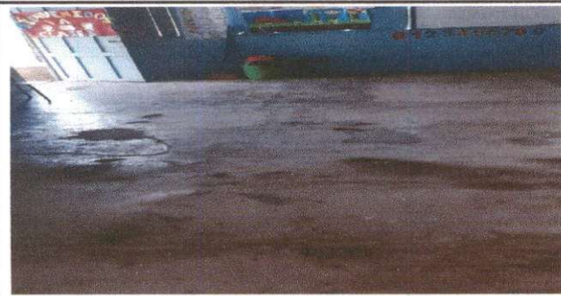
Foto 3: Reparación de piso de torta de concreto
