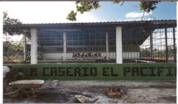
Foto 6: Finalización del comedor Escolar. Con sustitución de Láminas, capote, balcones, lavamanos, lavatrastos, puerta de metal y pintura en el interior y exterior del comedor.
