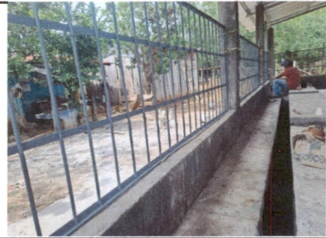
Foto 5: Finalización de los balcones de metal.
