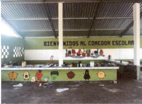
Foto 1: Finalización del comedor escolar con torta de cemento, desayunoador, estufa rural, lavamanos, lavatrastos.
