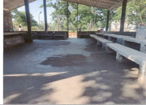
Foto 4: Sustitución de la torta de cemento.
