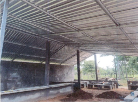
Foto 3: Finalización de la estructura.
