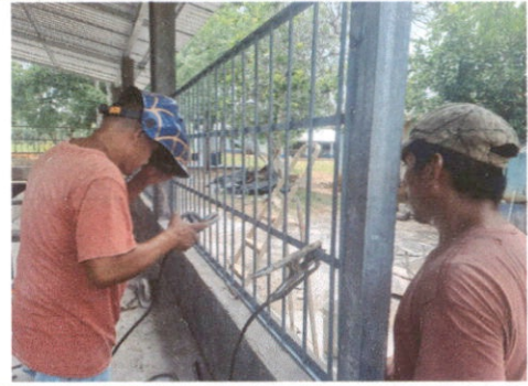
Foto 2: Esta imagen muestra el avance del balconeado de toda la vuelta de la cocina.
