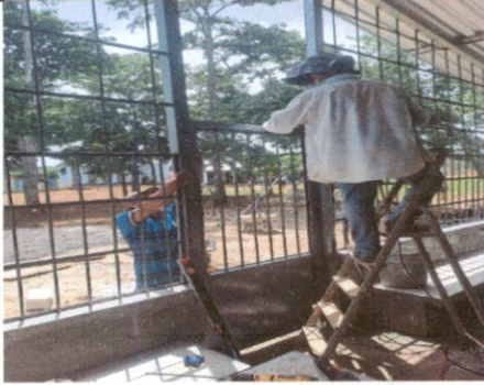
Foto 1: Es ilustración muestra el avance que se esta logrando con la instalacion de las puertas de metal por metal.
