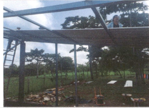
Foto 4: Sustitucion de lamina y capote.
