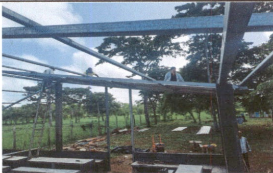
Foto 5: Sustitución de costanera de metal por metal.
