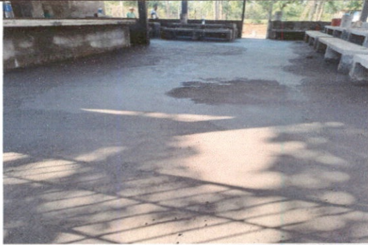
Foto 3: Se cambio la torta de cemento anterior por esta nueva.
