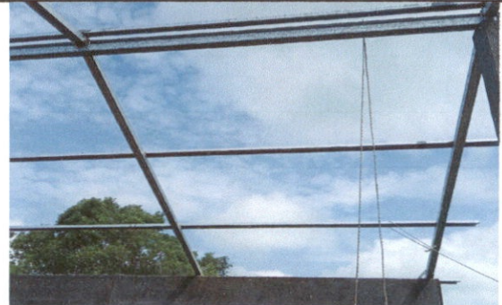
Foto 6: Sustitucion de estructura de soporte de metal.
