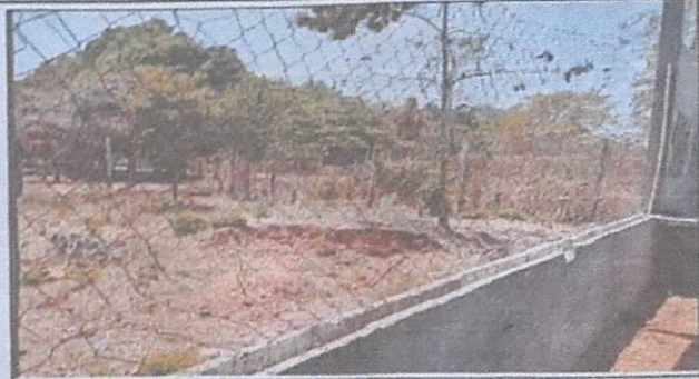
Foto 2: Sustitucion de balcones de metal
