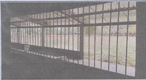
Foto 3: Sustitucion de balcones de metal
