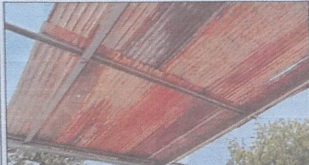
Foto 1: Sustitucion de lamina, caPote y estructura de soPorte de metal.
