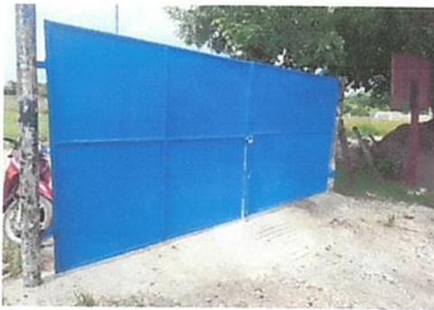
Foto 5: Mantenimiento a estructura (lijado, cambio de tubo, cepillado, sujeción, aplicación de pintura)
