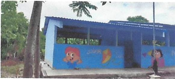
Foto 3: Sustrucción de lámina por lámina troquelada aluzin caibre 26
