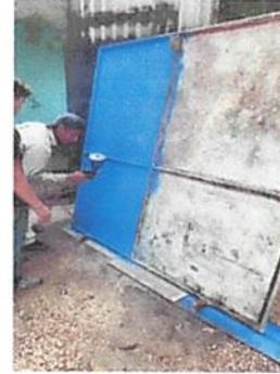
Foto 2: Mantenimiento a estructura (lijado, cambio de tubo, cepillado, sujeción, aplicación de pintura)
