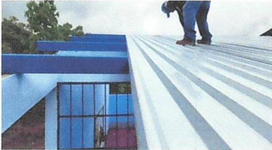
Foto1: Sustitución de lámina por lámina troquelada aluzin caibre 26
