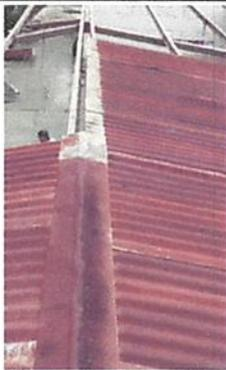
Foto 3: Sustitución de lámina por lámina troquelada aluzin caibre 26
