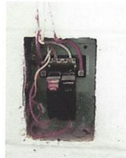
Foto 6: Sustitución de flipones y tablero de flipones, sustitución de cableado eléctrico, cableado doble y tomacorrientes
