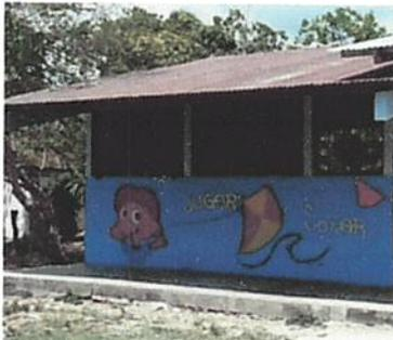
Foto 3: Sustitución de lámina por lámina troquelada aluzin caibre 26
