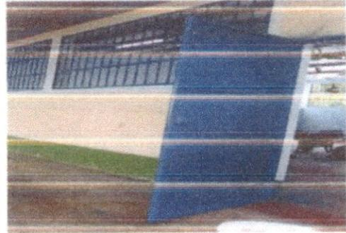
Mantenimiento a Estructura (lijado,cambio de tubo,cepillado, sujeciones, aplicación de pintura)
