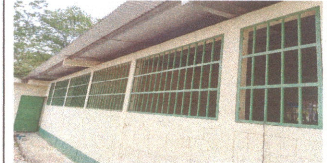
Pintura en muros exteriores e interiores
