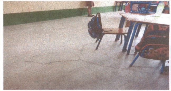
Sustitución de piso de torta de concreto
