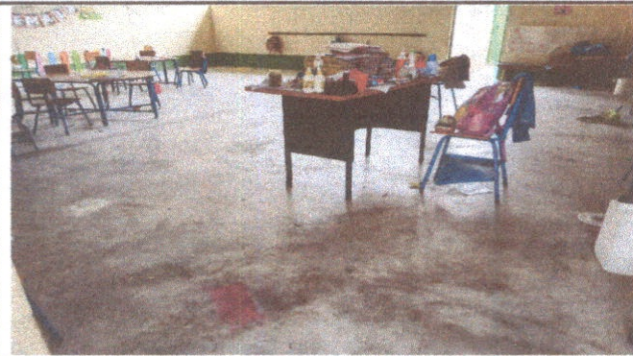
Sustitución de piso de torta de concreto
