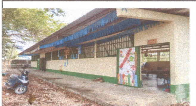
Pintura en muros exteriores e interiores
