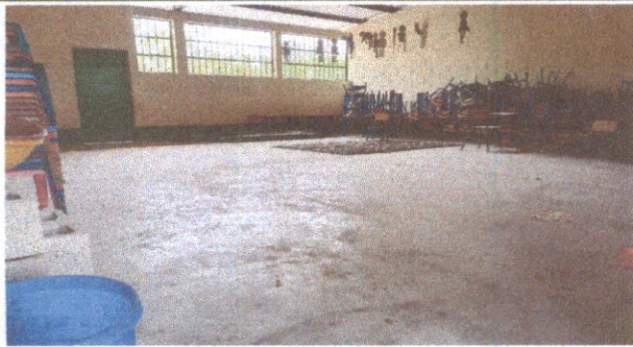
Sustitución de piso de torta de concreto
