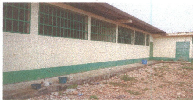
Pintura en muros exteriores e interiores
