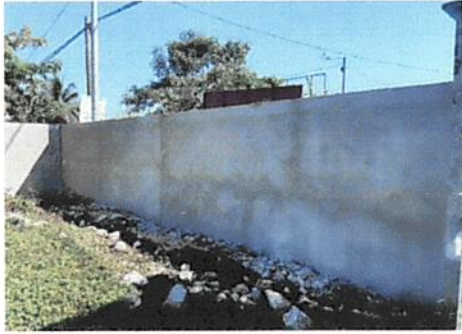
Foto 7: Reparación de muro perimetral
