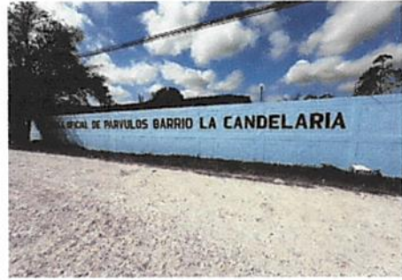
Foto 8: Pintura en Muros exteriores.
