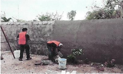
Foto 7: Reparación de muro perimetral
