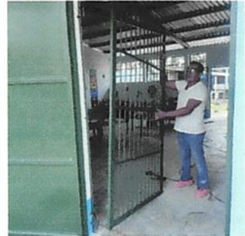
Foto 4: Fabricación e instalación de puerta de rejas
