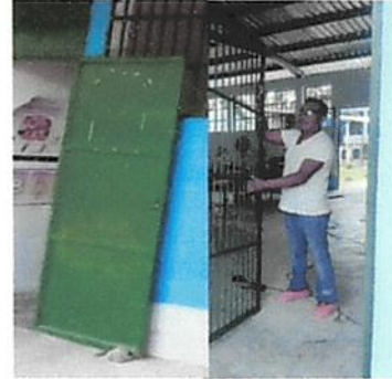
Foto 2: Mantenimiento de Estructura Puertas de Metal
