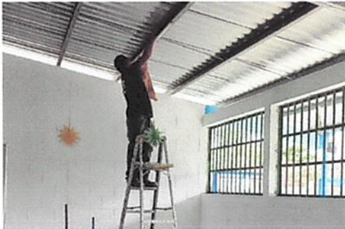
Foto 9: Sustitución de lámparas 2 X 40
