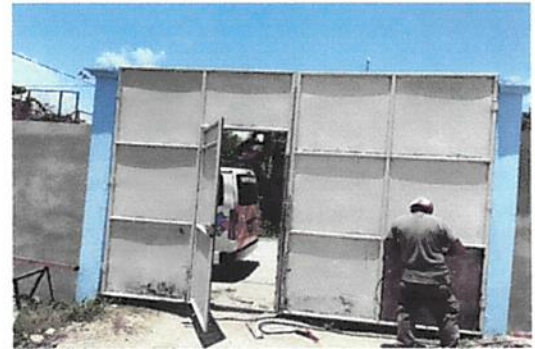
Foto 6: Mantenimiento de porton de metal
