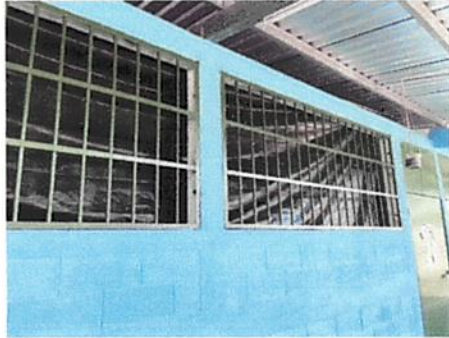
Foto 3: Mantenimiento de Balcones de metal
