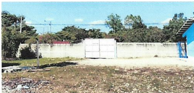
Foto 7: Reparación de muro perimetral
