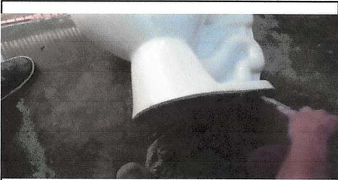
Foto1: Sustitucion de inodoros
