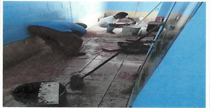
Foto 4: sustitucion de piso ceramico
