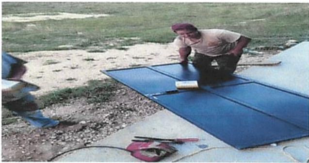
Foto 3: sustitucion de chapas
