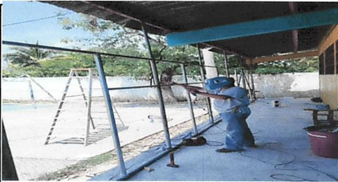
Foto 5: sustitucion de baranda de metal
