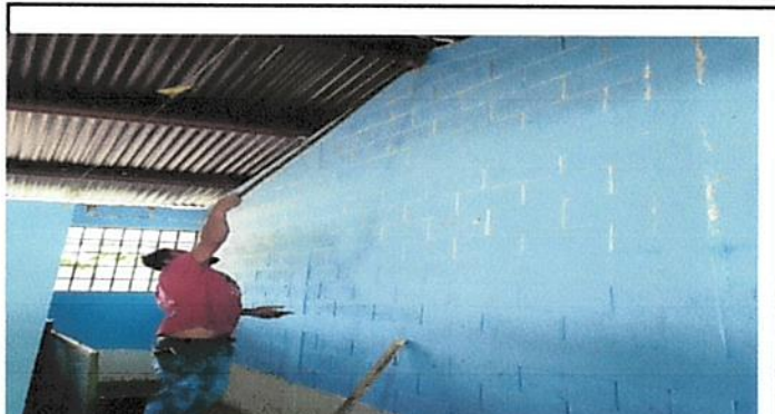
Foto 2: pintura en muros interior y exterior
