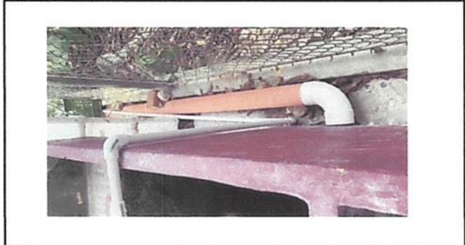
Foto 2: 14.3 Sustitución de tubería pvc línea principal aguas negras
