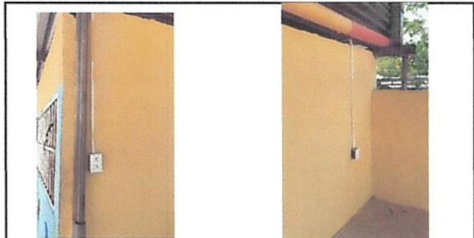
Foto 4: 17.12 sustitución de ducto eléctrico más accesorios
