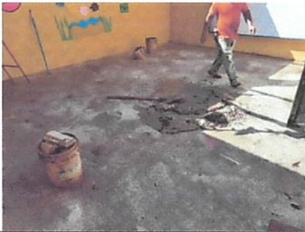
Foto 3: 6.1 reparación de piso de torta de concreto
