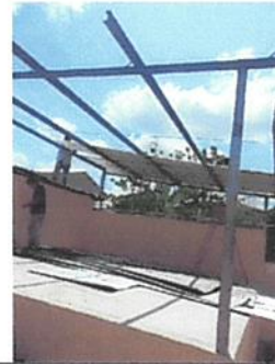
Foto 2: 1.1 Sustitución de lámina, por lámina troquelada aluzinc calibre 2
