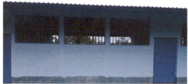
PINTURA EN MURO EXTERIOR E INTERIOR
