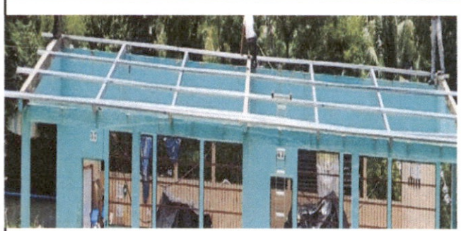
SUSTITUCIÓN DE ESTRUCTURA DE SOPORTE DE METAL, POR METAL
