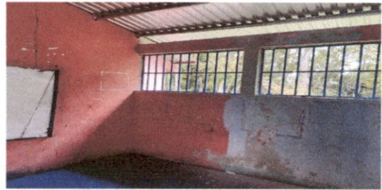
SUSTITUCIÓN DE BALCON DE METAL
