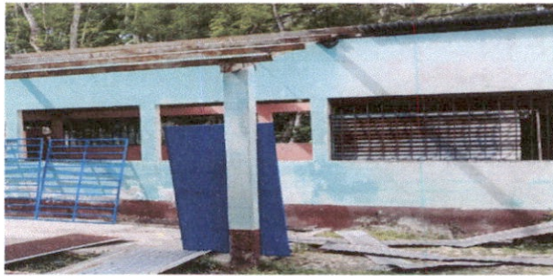
SUSTITUCIÓN DE PUERTA
