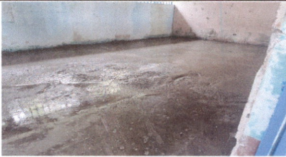
SUSTITUCIÓN DE TORTA DE CONCRETO
