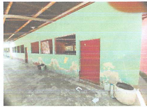
SUSTITUCIÓN DE TORTA DE CONCRETO
