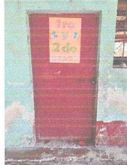
SUSTITUCIÓN DE PUERTA
