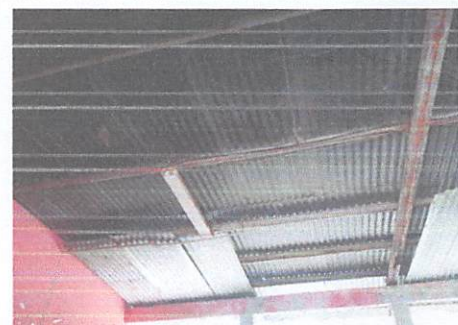
SUSTITUCIÓN DE DUCTO+ACCESORIOS
