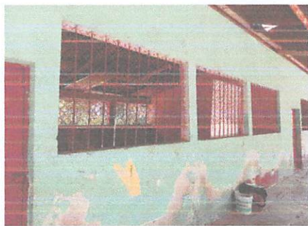
PINTURA EN MUROS EXTERIOR E INTERIOR
