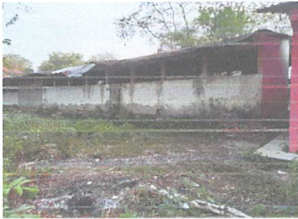
SUSTITUCIÓN DE LAMINA POR LAMINA TROQUELADA ALUZINC CALIBRE 26
