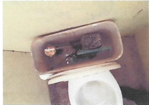
sustitucion de accesorios de inodoro
