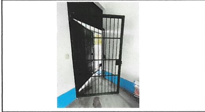
Foto 4: Fabricacion e instalacion de puertas de rejas.
