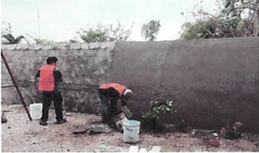
Foto 7: Reparación de muro perimetral
