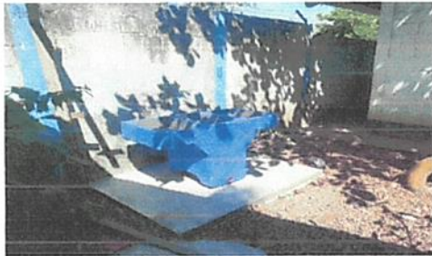
sustitucion de pila
