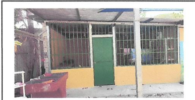
Foto 5: 4.3 sustitución de puerta
