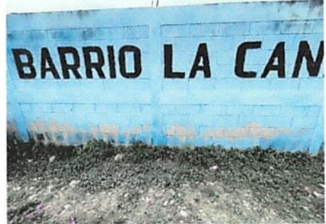
Foto 8: Pintura en muros exteriores
