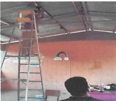
sustitucion de toma corrientes dobles
