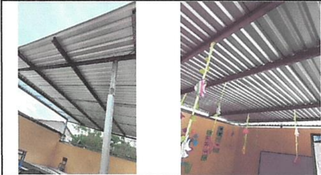
Foto 1: 1.1 Sustitución de lámina, por lámina troquelada aluzinc calibre 26
