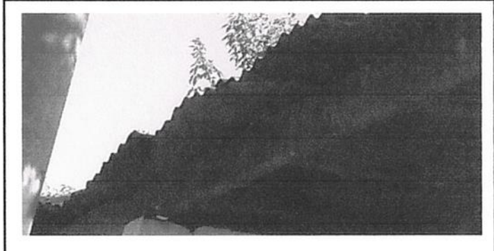
Foto 2: 12.1 Mantenimiento de estructura de soporte de metal
