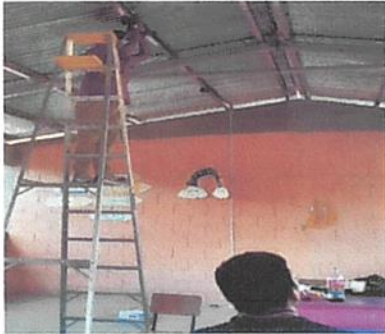
reparacion de cableado principal
