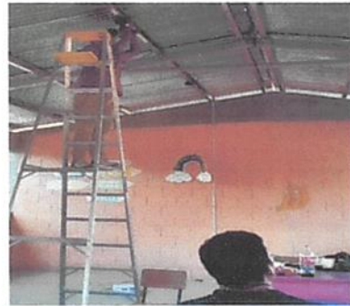
sustitucion de plafoneras
