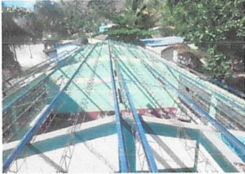
sustitucion de costaneras de metal por metal
