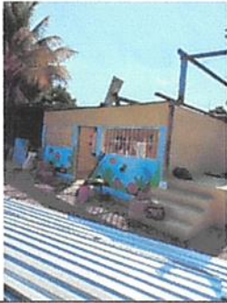
Foto 1: 1.1 Sustitución de lámina, por lámina troquelada aluzinc calibre 26
