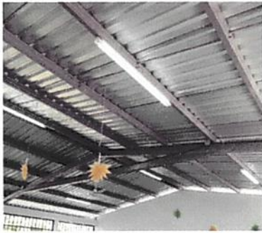
Foto 9: Sustitución de lámparas 2 X 40
