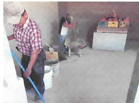
Foto 4: 6.1 reparación de piso de torta de concreto
