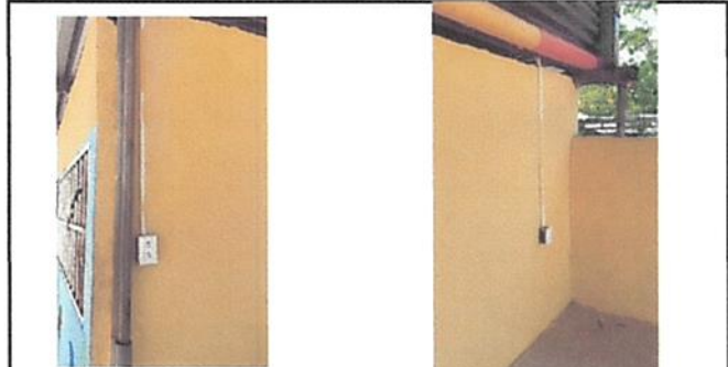
Foto 4: 17.12 sustitución de ducto eléctrico más accesorios
