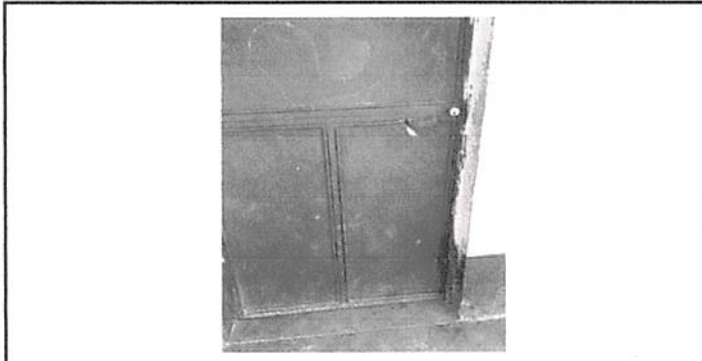
Foto 5: 4.2 Sustitución de chapa 4.3 Sustitución de puerta
