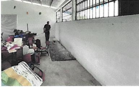
Foto 1: Pintura en muros exteriores e interiores
