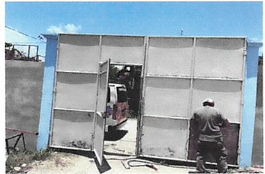
Foto 6: Mantenimiento de porton de metal
