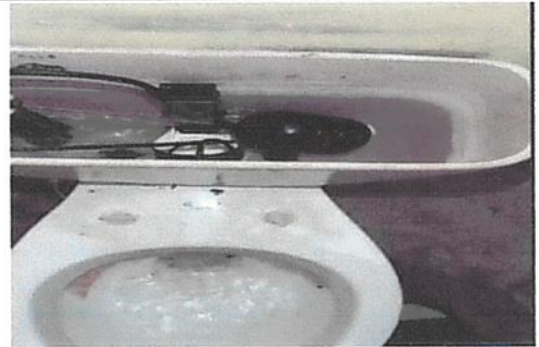
sustitucion de accesorios de inodoro
