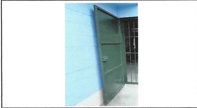
Foto 2: Mantenimiento de estructura de puertas de metal
