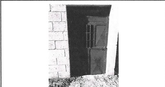
Foto 3: 4.2 Sustitución de chapa 4.3 Sustitución de puerta
