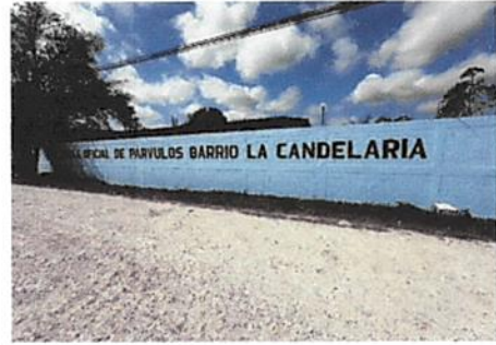
Foto 8: Pintura en Muros exteriores.
