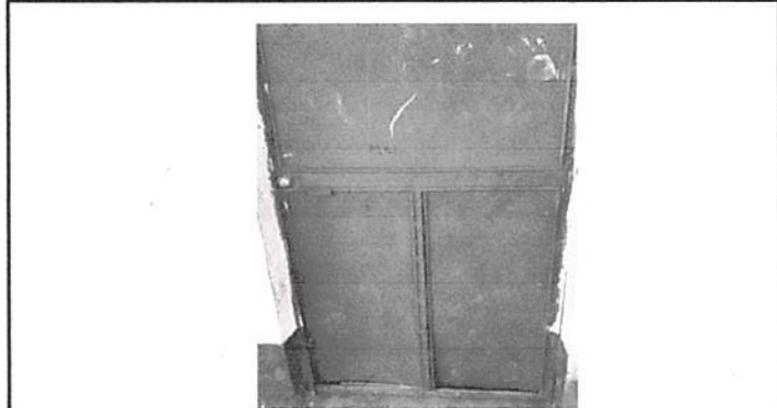
Foto 4: 4.2 Sustitución de chapa 4.3 Sustitución de puerta
