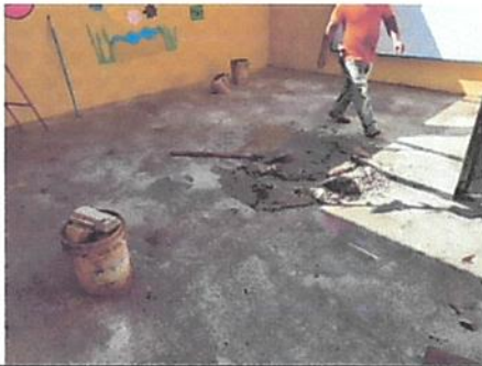
Foto 3: 6.1 reparación de piso de torta de concreto
