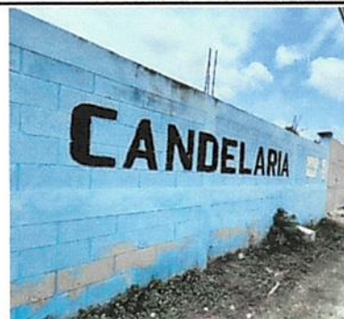
Foto 8: Pintura en muros exteriores
