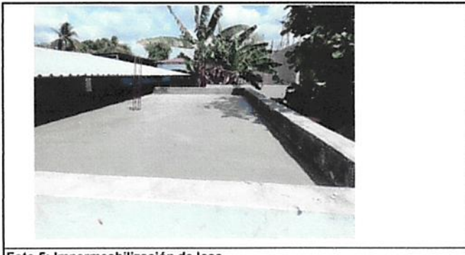
Foto 5: Impermeabilización de losa
