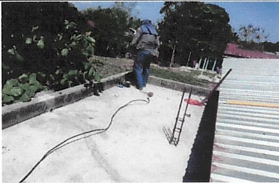
Foto 6: Impermeabilización de Losa.
