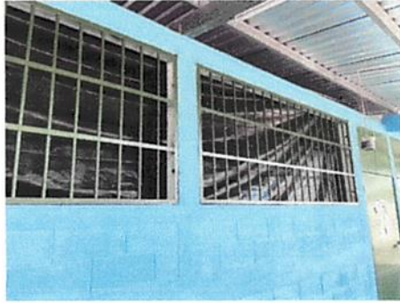
Foto 3: Mantenimiento de Balcones de metal
