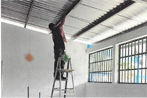
Foto 9: Sustitución de lámparas 2 X 40
