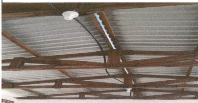
Foto 3: Sustitución de ducto electrico mas accesorios
