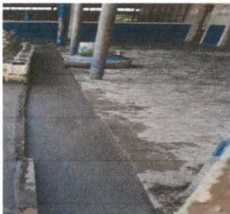
Foto 5: Reparación de cuneta de concreto
