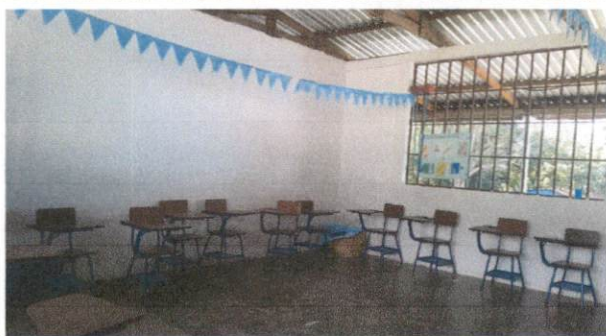
Foto 5: Pintura en muros exterior e interior
