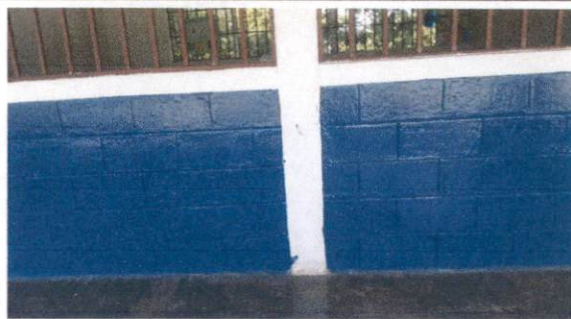
Foto 4: Pintura en muros exterior e interior
