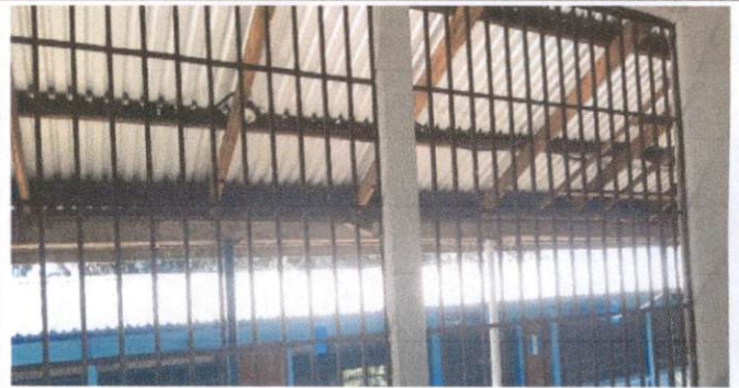
Foto 2: Mantenimiento de estructura de metal de ventanas
