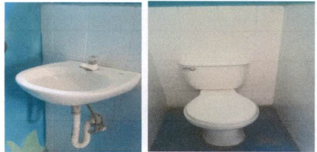
Foto 4: Sustitución de inodoros y accesorios
