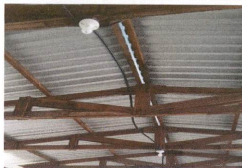
Foto 6: Sustitución de ducto electrico mas accesorios
