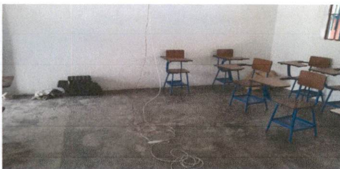
Foto 3: Reparación de cableado Electrico
