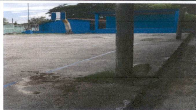
Foto 2: Reparación de cuneta de concreto
