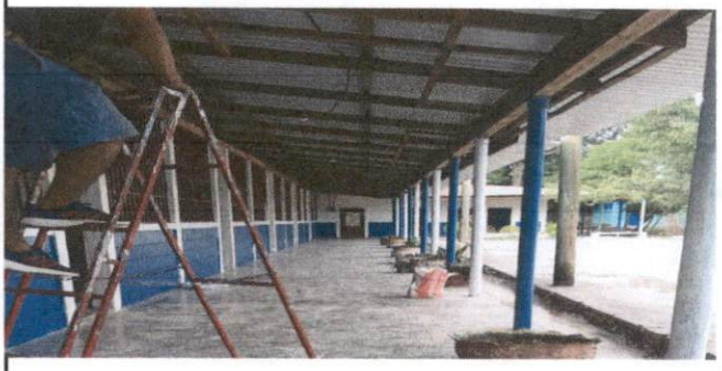
Foto 4: Sustitución de ducto Electronico
