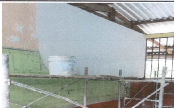
Foto 2: Pintura a muros exterior e interior
