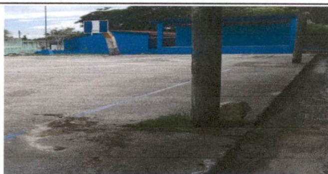
Foto 3: Reparación de cuneta de concreto
