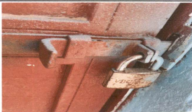
Foto 5: Sustitución de chapas
