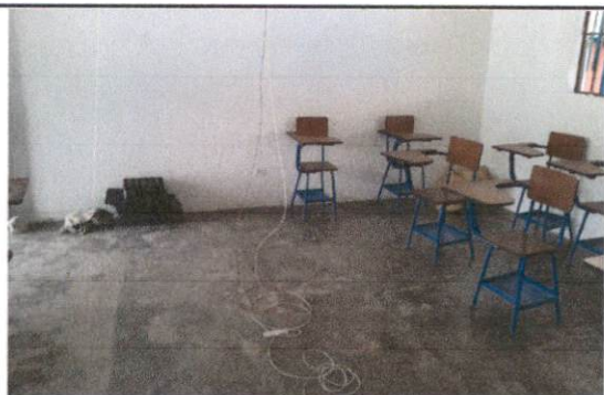
Foto 5: Reparación de cableado electrico
