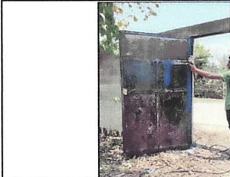
**Foto1: PUERTA ACCESO PRINCIPAL A LA ESCUELA 4.1 Mantenimiento a estructura (lijado, cambio de tubo , cepillado, sujeciones, aplicación de pintura) DURANTE PROCESO DE MANTENIMIENTO.**
