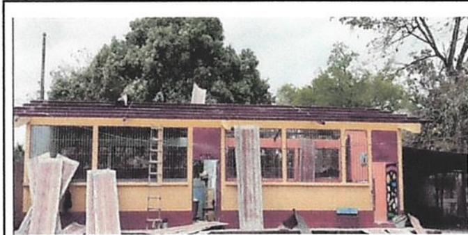
**Foto 3: 1.1 Sustitución de lámina, por lámina troquelada aluzinc calibre 26. DURANTE PROCESO DE SUSTICIÓN.**
