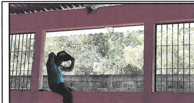
**Foto 5: (Aula 2 Ventana) 5.2 Sustitución de estructura de metal de ventana. (Aula 2 Puerta)4.1 Mantenimiento a estructura (lijado, cambio de tubo , cepillado, sujeciones, aplicación de pintura) DURANTE PROCESO DE SUSTITUCIÓN.**
