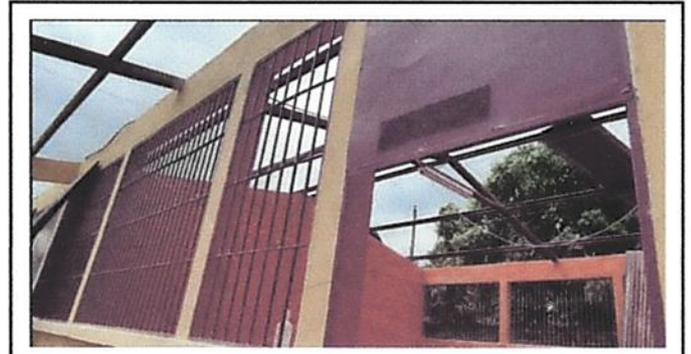
Foto 8: (Aula 2) 2.3 Sustitución de estructura de soporte de metal, por metal. DURANTE PROCESO DE SUSTITUCIÓN.
