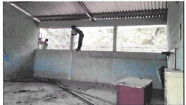
**Foto 4: (Aula 1 Ventana) 5.2 Sustitución de estructura de metal de ventana. (Aula 1 Puerta)4.1 Mantenimiento a estructura (lijado, cambio de tubo , cepillado, sujeciones, aplicación de pintura) DURANTE PROCESO DE SUSTITUCIÓN.**
