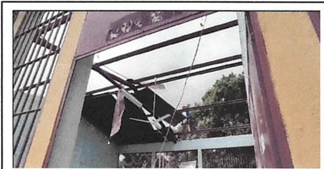
Foto 9: (Aula 1) 2.3 Sustitución de estructura de soporte de metal, por metal. DURANTE PROCESO DE SUSTITUCIÓN.
