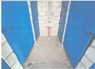
SUSTITUCION DE TORTA DE CEMENTO
