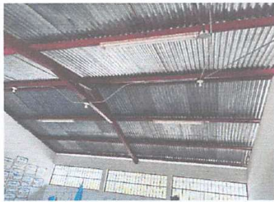
SUSTITUCIÓN DE DUCTO ELÉCTRICO MAS ACCESORIOS
