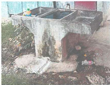
SUSTITUCIÓN DE PILA DE DOS LAVADEROS
