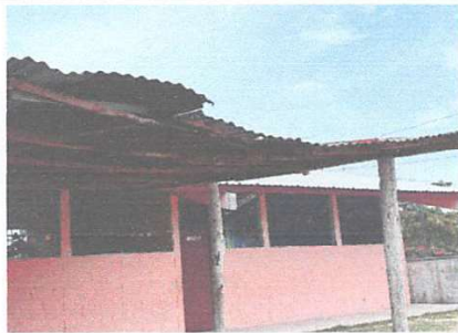
SUSTITUCIÓN DE CUBIERTA DE LAMINA POR LAMINA TROQUELADA ALUZINC CALIBRE 26
