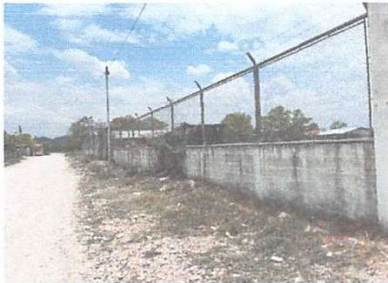
APLICACIÓN DE PINTURA EN MURO INTERIOR Y EXTERIOR
