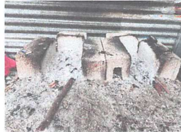
SUSTITUCIÓN DEL POYETÓN
