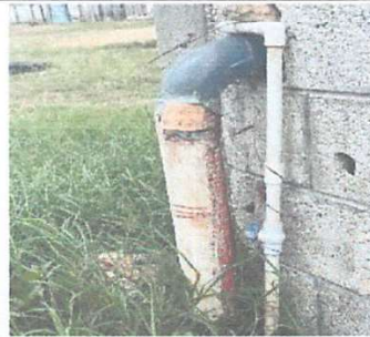
SUSTITUCIÓN DE TUBERIA PVC LINEA PRINCIPAL AGUAS NEGRAS
