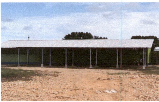
SUSTITUCIÓN DE LÁMINA POR LÁMINA TROQUELADA
