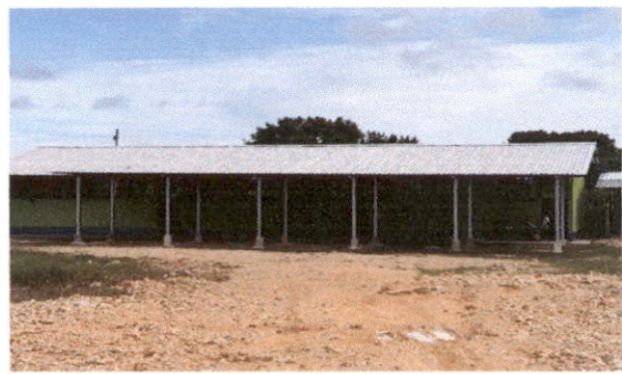
SUSTITUCIÓN DE SOPORTE DE METAL
