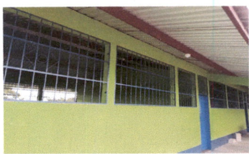
APLICACIÓN DE PINTURA EN MURO INTERIOR Y EXTERIOR
