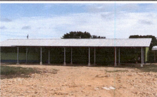
SUSTITUCIÓN DE COSTANERA
