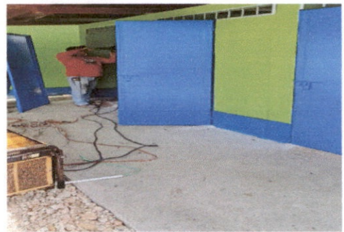
SUSTITUCIÓN DE TORTA DE CEMENTO
