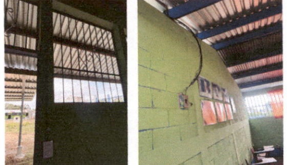
SUSTITUCIÓN DE CABLEADO PRINCIPAL
