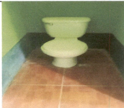
SUSTITUCIÓN DE INODORO
