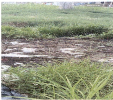
LIMPIEZA DE FOSA SEPTICA
