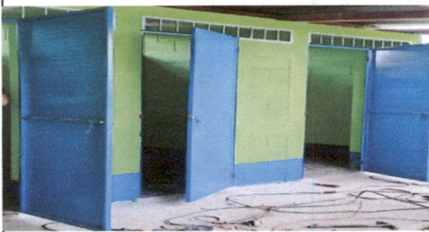
SUSTITUCIÓN DE PUERTA EN SERVICIO SANITARIO
