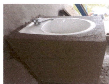
SUSTITUCIÓN DE LAVAMANOS
