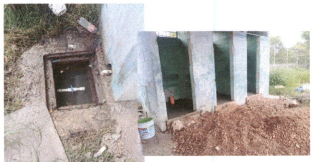
LIMPIEZA DE FOSA SEPTICA
