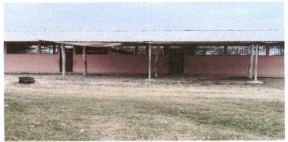
SUSTITUCIÓN DE CHAPA
