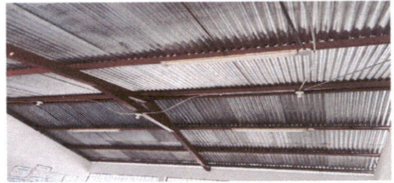
SUSTITUCIÓN DE CABLEADO PRINCIPAL
