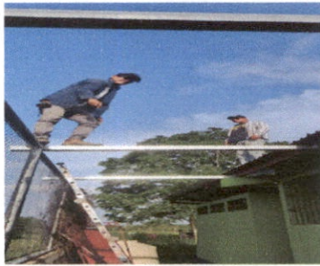
SUSTITUCIÓN DE COSTANERA
