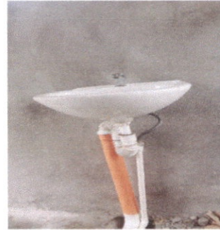
SUSTITUCIÓN DE LAVAMANOS
