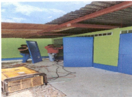
SUSTITUCIÓN DE PUERTA EN SERVICIO SANITARIO
