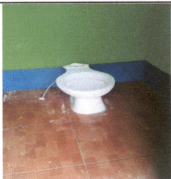
SUSTITUCIÓN DE INODORO
