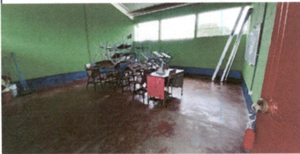
APLICACIÓN DE PINTURA EN MURO INTERIOR Y EXTERIOR
