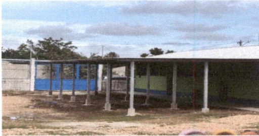
SUSTITUCIÓN DE LÁMINA POR LÁMINA TROQUELADA
