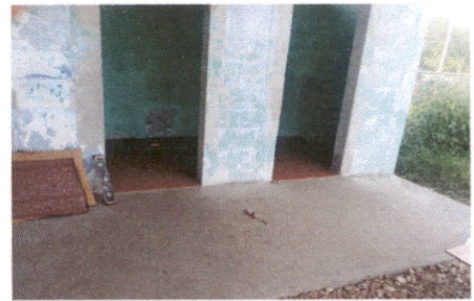
SUSTITUCIÓN DE TORTA DE CEMENTO
