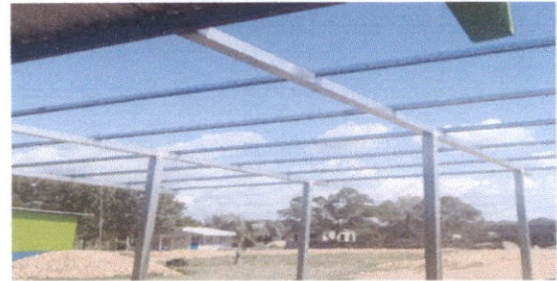
SUSTITUCIÓN DE SOPORTE DE METAL
