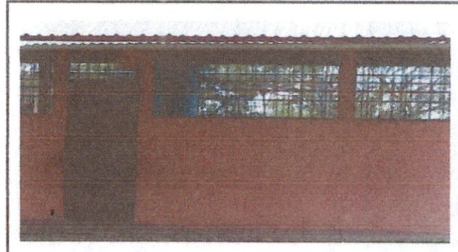
SUSTITUCIÓN DE CHAPA
