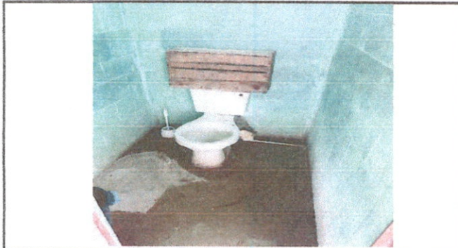
SUSTITUCIÓN DE INODORO
