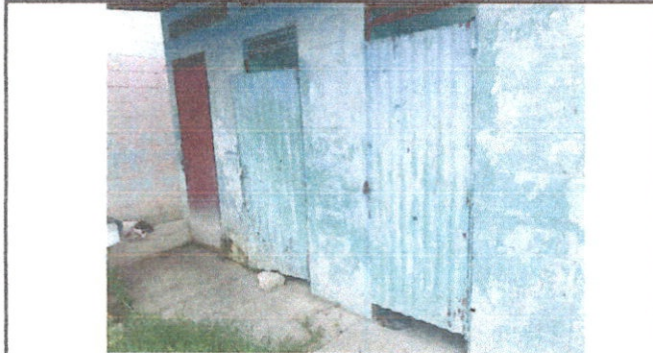
SUSTITUCIÓN DE PUERTA EN SERVICIO SANITARIO
