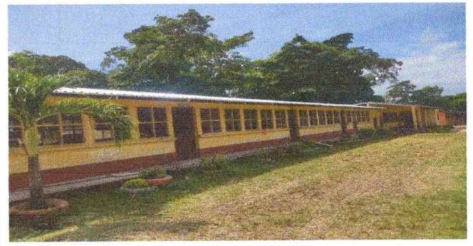
Finalización de instalación de lámina troquelada.
