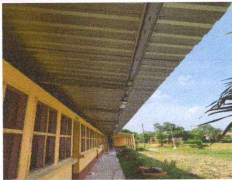
Sustitución de bombillas.
