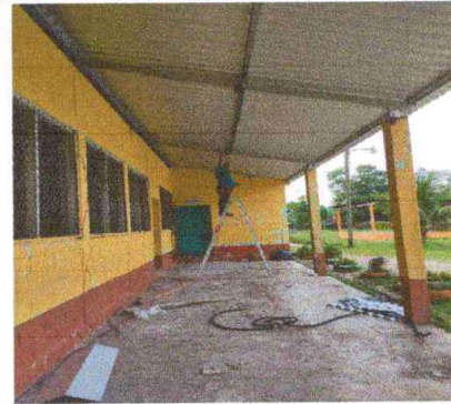
Reparación de cableado eléctrico.
