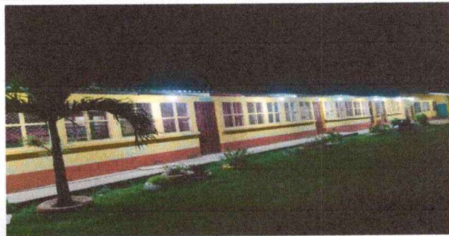
Finalización de sustitución de cableado eléctrico.
