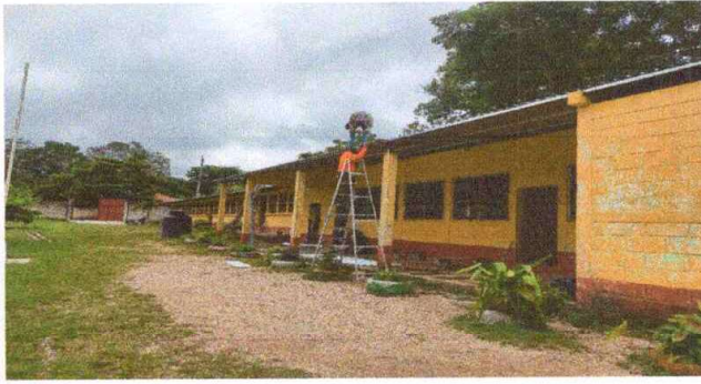
Instalación de lámina por lámina troquelada.
