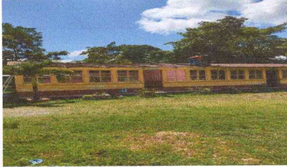
Desinstalación de lámina.
