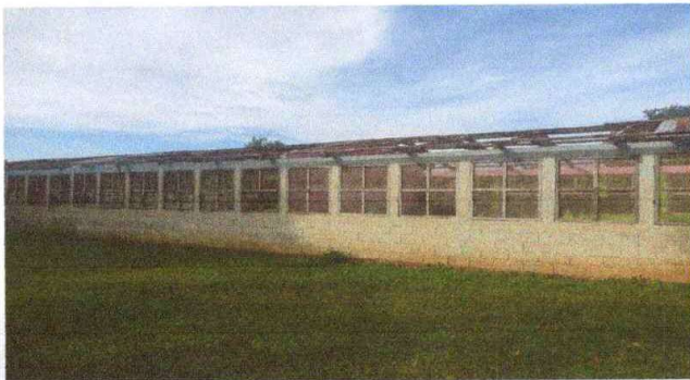
Desinstalación de estructura de madera.
