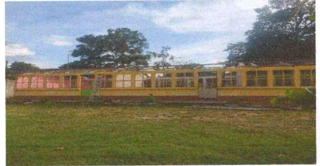
Desinstalación de estructura de madera.
