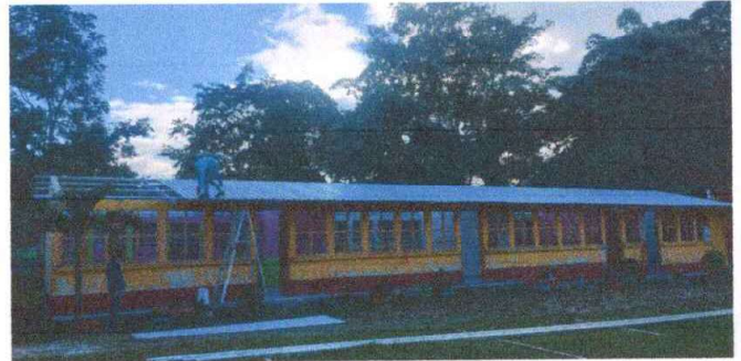
Instalación de lámina troquelada.
