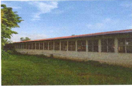
Sustitución de lámina por lámina troquelada.
