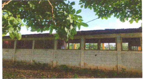
Sustitución de capote de lámina para lámina troquelada.
