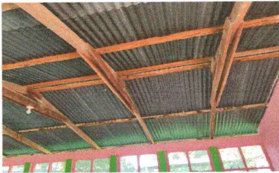
Sustitución de estructura de soporte de madera por metal.
