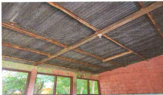
Reparación de cableado eléctrico.
