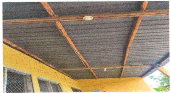
Reparación de cableado eléctrico.
