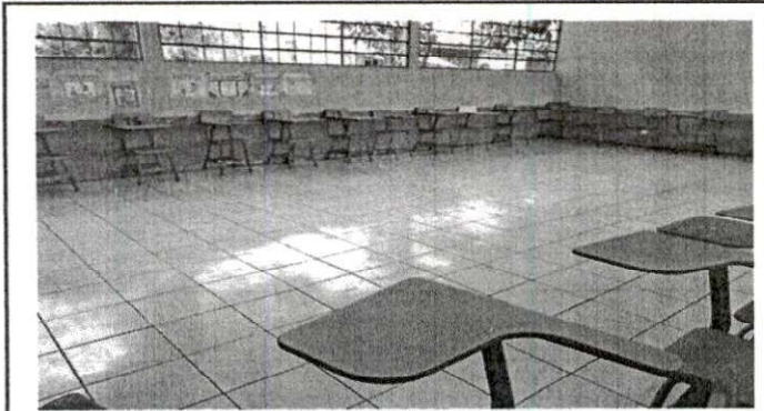
Foto 1. Sustitucion de piso ceramico
