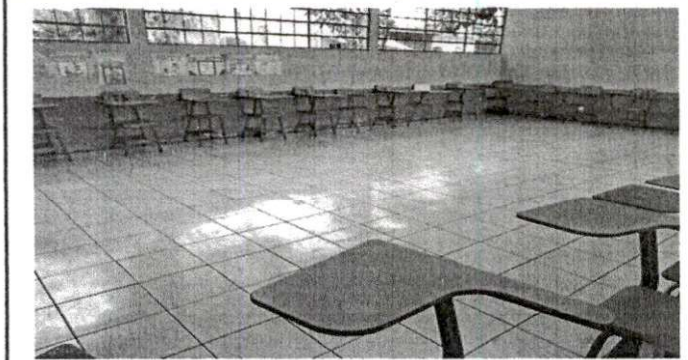
Foto 1. Sustitución de piso ceramico
