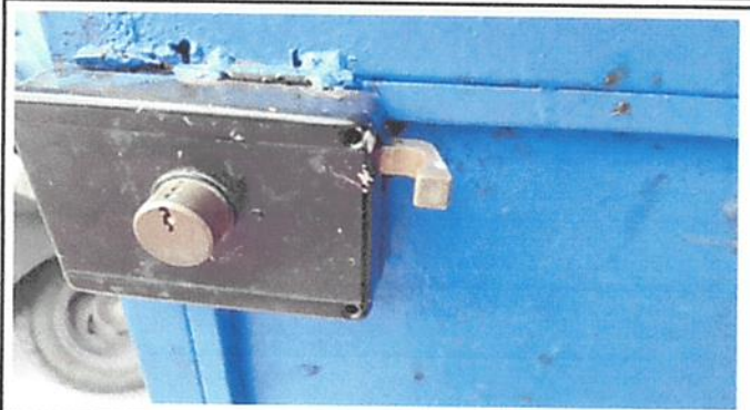
Foto 2: 4.2 Sustitución de chapa
