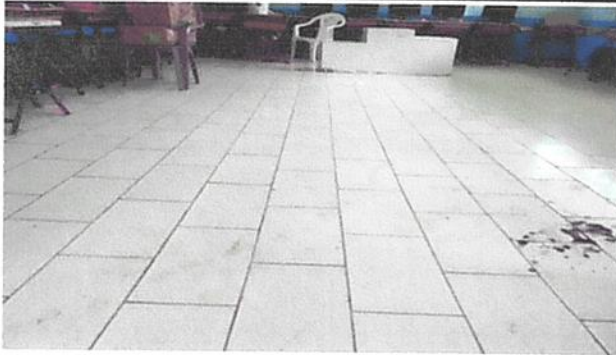
Foto 3: 6.8 Sustitución de piso cerámico
