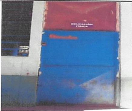
Foto1: 4.1 Mantenimiento a estructura (lijado, cambio de tubo, cepillados, sujecciones, aplicación de pintura).
