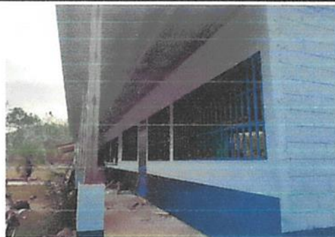
Sustitución de puertas de metal
