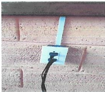
Sustitucion de tomacorrientes dobles
