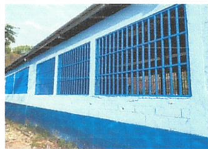
sustitución de balcones de metal
