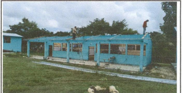
SUSTITUCION DE ESTRUCTURA SOPORTE DE MADERA POR METAL
