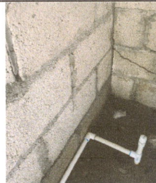
SUSTITUCION DE LAVAMANOS
