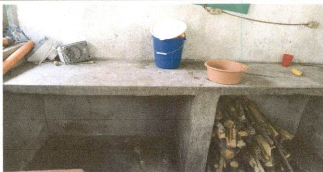
REPARACION DE AZULEJOS EN MUEBLES DE COCINA
