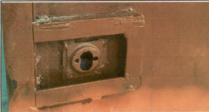
SUSTITUCION DE CHAPA
