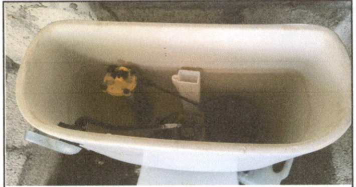
SUSTITUCION DE ACCESORIOS DE INODORO
