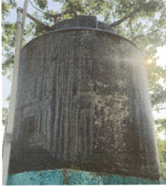
SUSTITUCION DE DEPOSITO DE AGUA 1,700 LT
