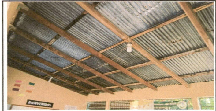
SUSTITUCION DE ELEMENTOS DE FIJACION
