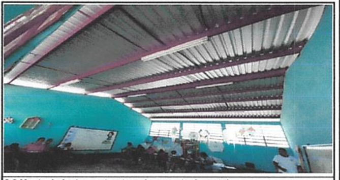
2.2 Mantenimiento a estructura de soporte de metal
