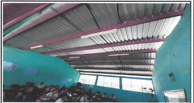
2.2 Mantenimiento a estructura de soporte de metal
