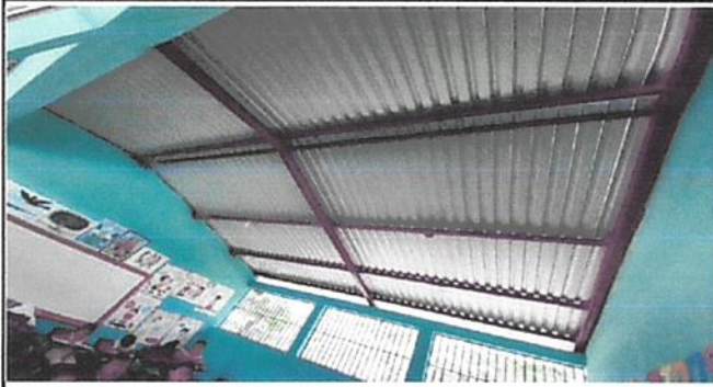
1.1 Sustitución de lámina, por lámina troquelada aluzinc calibre 26
