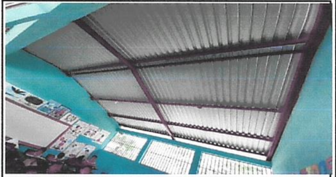
2.2 Mantenimiento a estructura de soporte de metal
