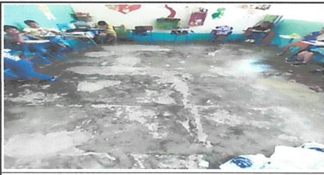
6.5 Sustitución de piso de torta de concreto
