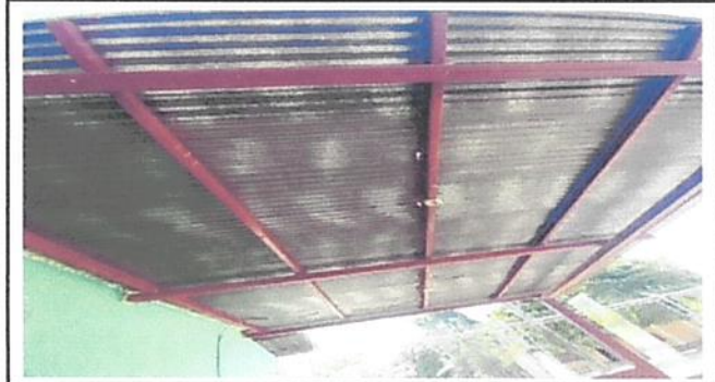
1.1 Sustitución de lámina, por lámina troquelada aluzinc calibre 26
