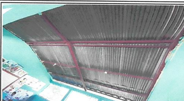
2.2 Mantenimiento a estructura de soporte de metal
