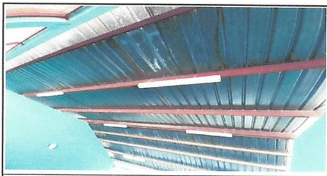
1.1 Sustitucion de lamina por lamina troquelada de zinc calibre 26
