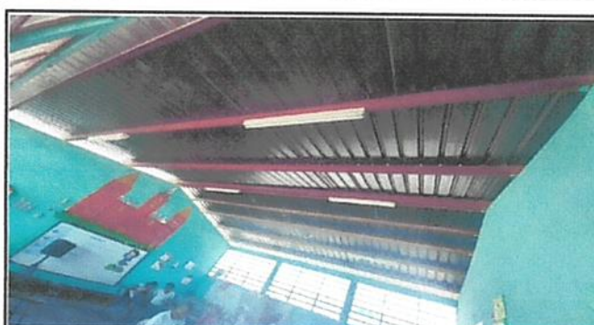
2.2 Mantenimiento a estructura de soporte de metal
