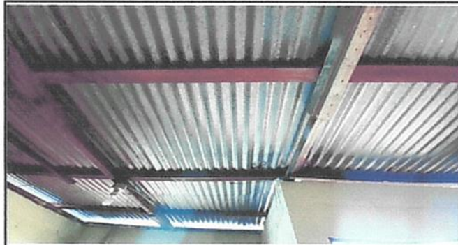
2.2 Sustitución de estructura de soporte de madera, por metal
