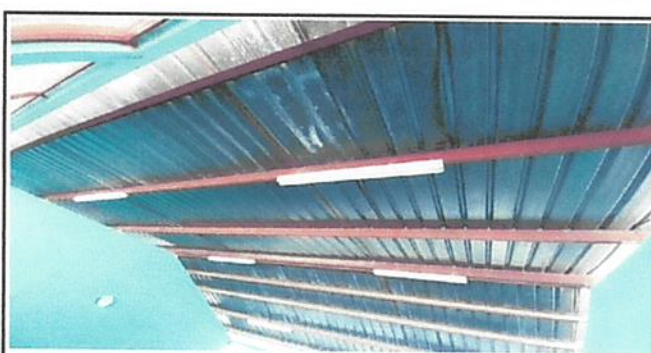
2.2 Mantenimiento a estructura de soporte de metal
