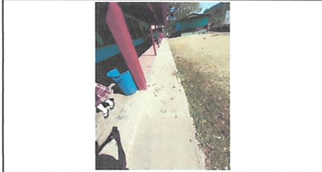
6.5 Sustitución de Piso de torta de concreto
