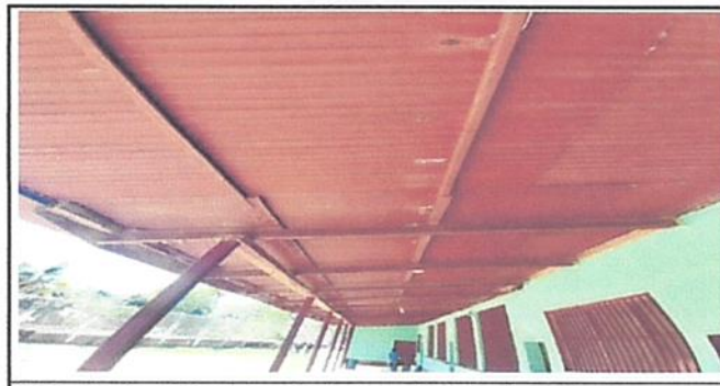
1.1 Sustitución de lámina por lámina troquelada de zinc calibre 26
