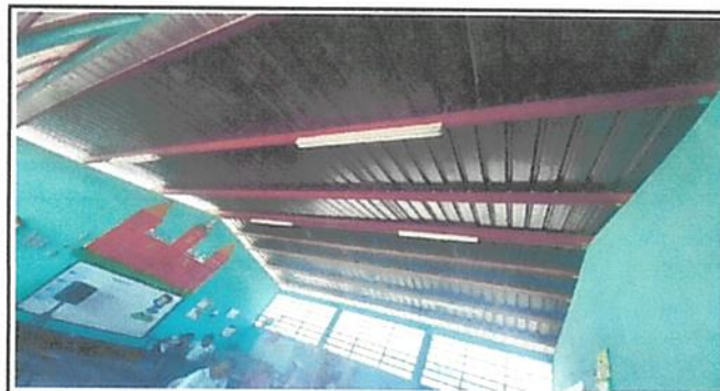
1.1 Sustitución de lamina por lamina troquelada de zinc calibre 26
