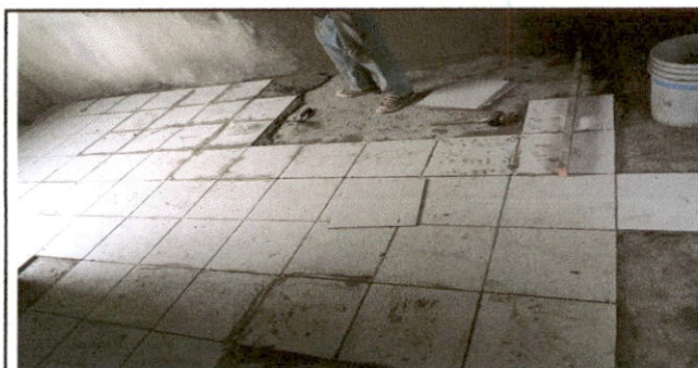
Foto 5: Remosamiento de piso ceramico y azulejos en baños
