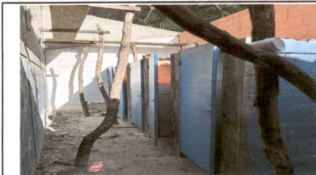
Foto1: Sustitución de Puertas de Baños
