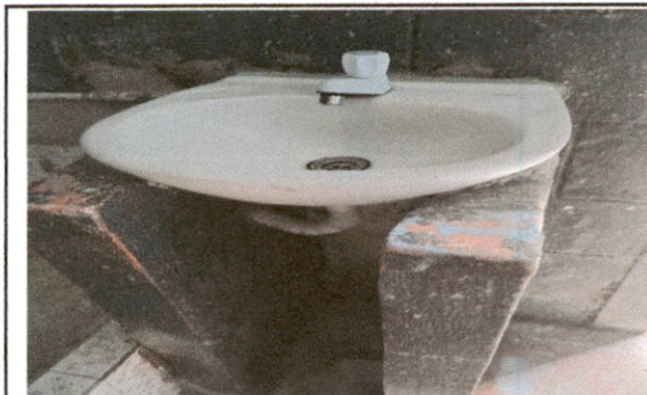
Foto 3: Sustitución de lavamanos
