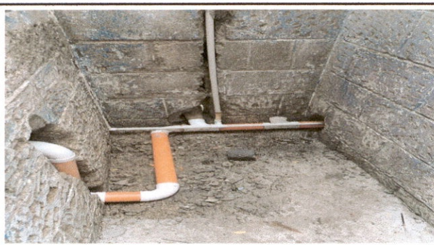
Foto 2: Sustitución de tuberías y llaves
