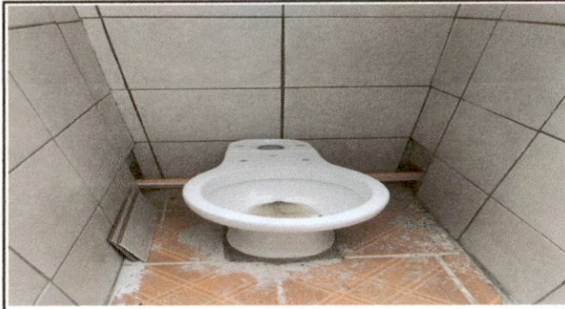
Foto 2: Sustitución de tazas de baños
