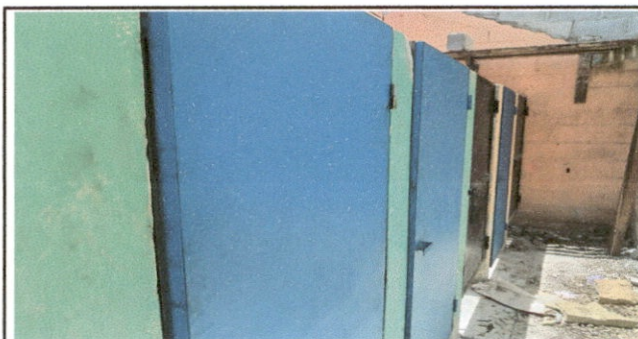
Foto 6: Sustitucion y elaboracion de puertas de baños principales
