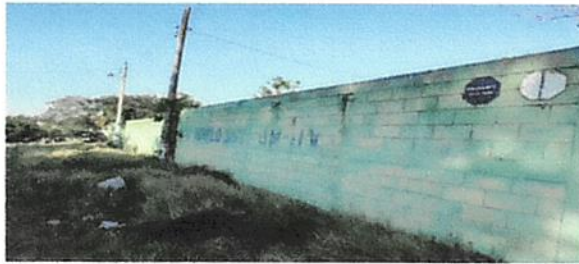
Foto 3: Pintura en muro de exterior e interior M2
