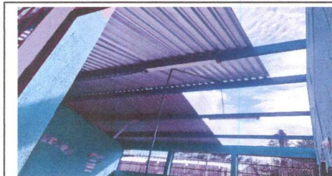
Foto 3: . Instalación de lámina troquelada de Alizinc
