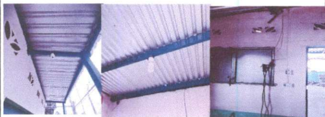
Foto 15 : Instalación de unidades de luz
