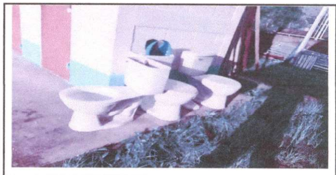
Foto 6: Sustitución de inodoro
