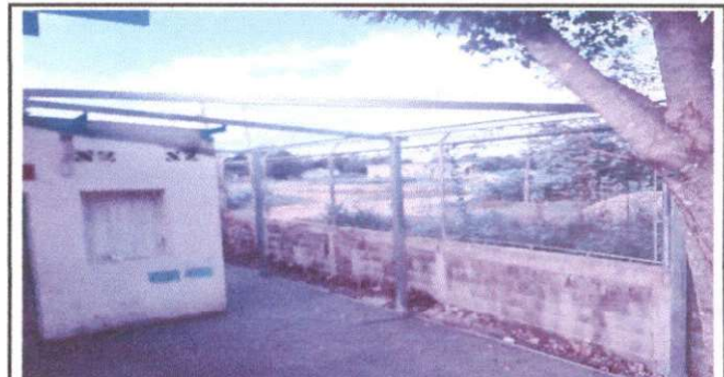
Foto 4: Mantenimiento de estructura portante de madera por metal.
