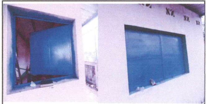
Foto 10: Sustitución de ventanas de madera por metal
