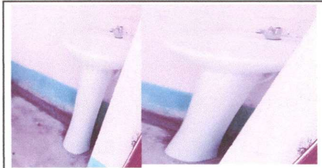
Foto 8: Sustitución de lavamanos
