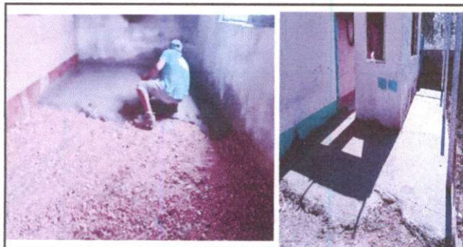
Foto 5: Sustitución de pisos de torta de concreto
