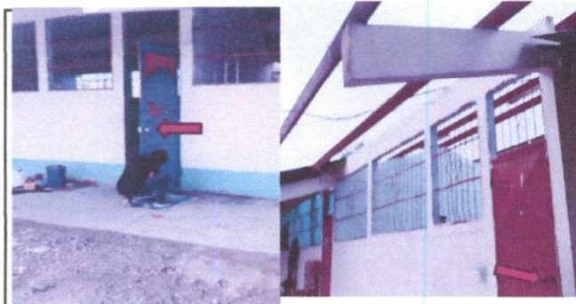
Foto 9: Sustitución de chapas
