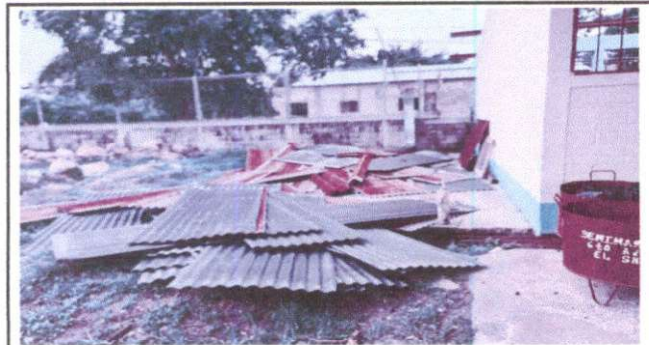
Foto1: Desinstalación de lámina existente
