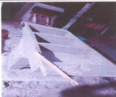
Foto 13: Sustitución de pila de concreto
