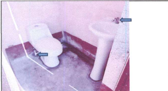
Foto 7: Sustitución de accesorios de baños
