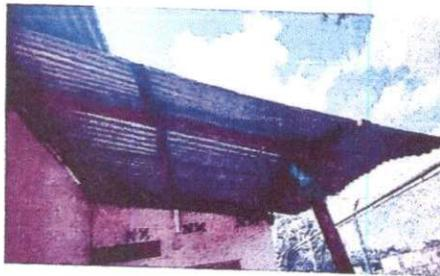
Sustitución de estructura de soporte de madera por metal.
