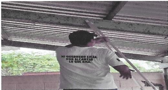
SUSTITUCIÓN DE FOCOS AHORRADORES
