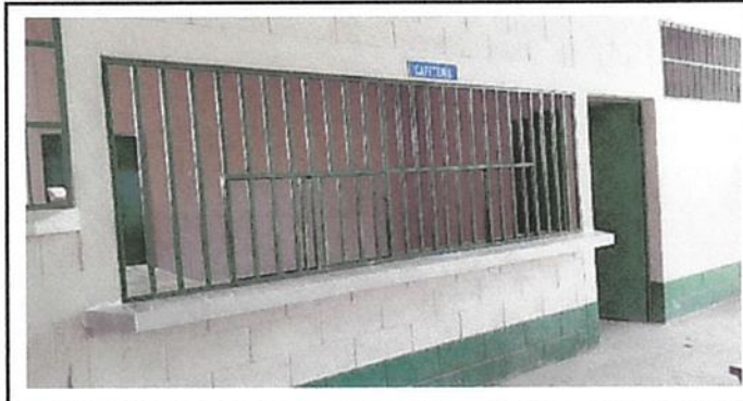
SUSTITUCIÓN DE BALCON
