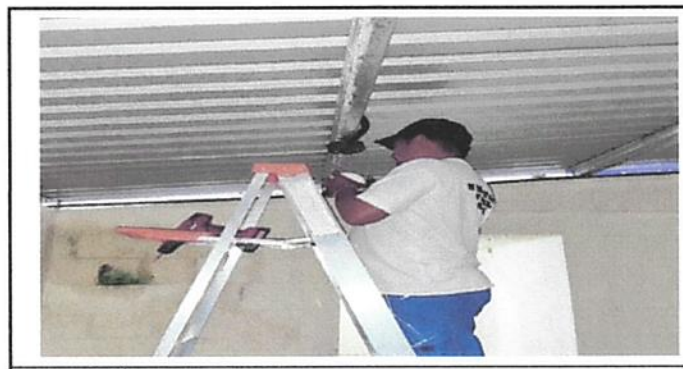
SUSTITUCIÓN DE PLAFONERA
