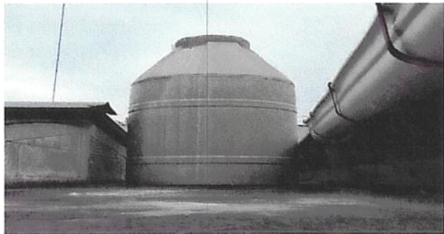
SUSTITUCIÓN DE ACCESORIOS DEPOSITO DE AGUA
