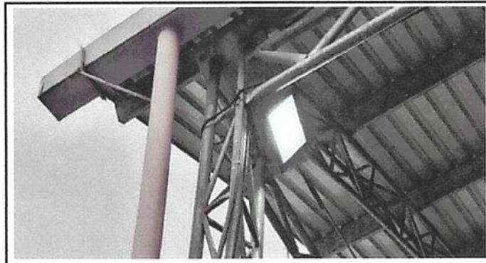
SUSTITUCIÓN DE REFLECTORES LED
