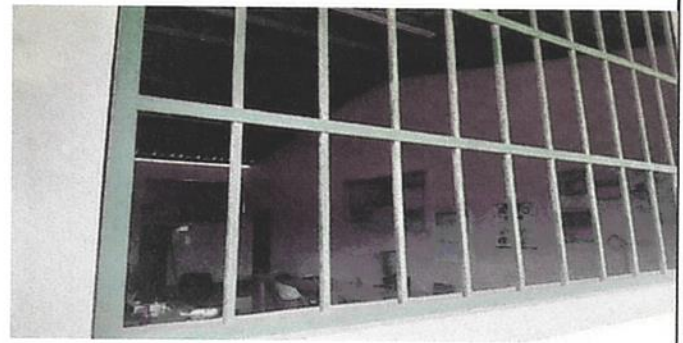
SUSTITUCIÓN DE BALCON
