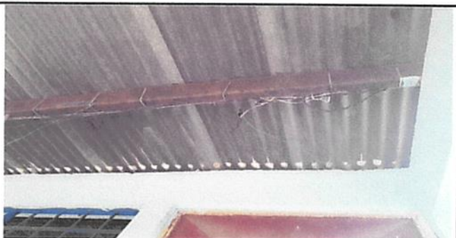
SUSTITUCIÓN DE CABLEADO PRINCIPAL
