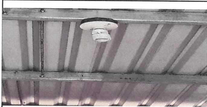
SUSTITUCIÓN DE FOCOS AHORRADORES
