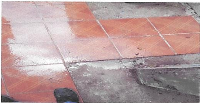
SUSTITUCIÓN DE CERÁMICA
