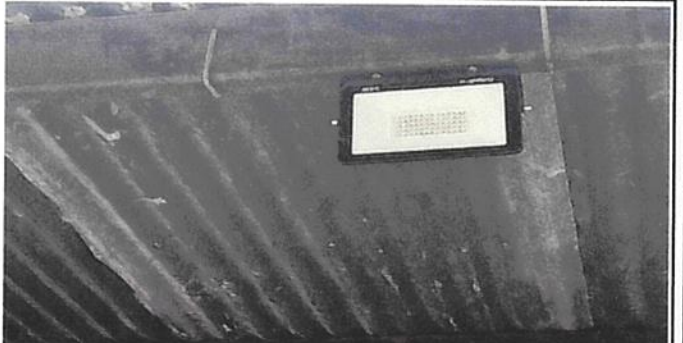
SUSTITUCIÓN DE REFLECTORES LED
