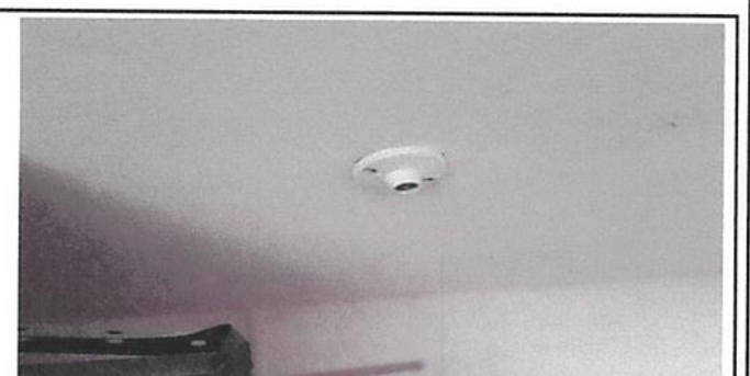
SUSTITUCIÓN DE PLAFONERA
