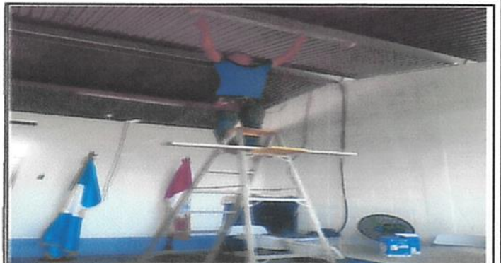
Foto 4: Sustitución de lámparas por bombillo led.
