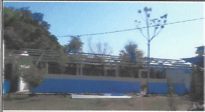
Foto 1: Instalación de lamina y realización de la estructura metálica.
