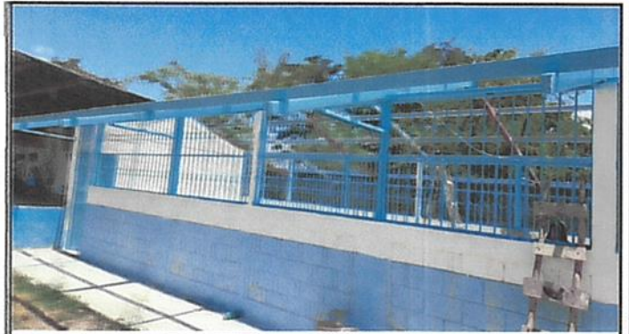
Foto 2: Mantenimiento a los varcos de la zona trabajada.
