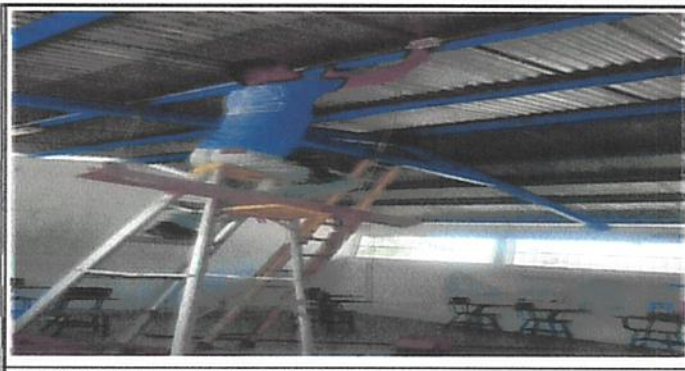
Foto 5: Sustitución del sistema eléctrico.
