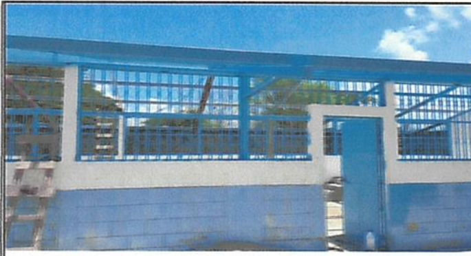
Foto 3: Mantenimiento a las puertas de la zona trabajada.
