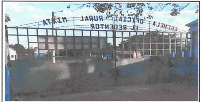
Foto 6: Mantenimiento al Porton de Metal
