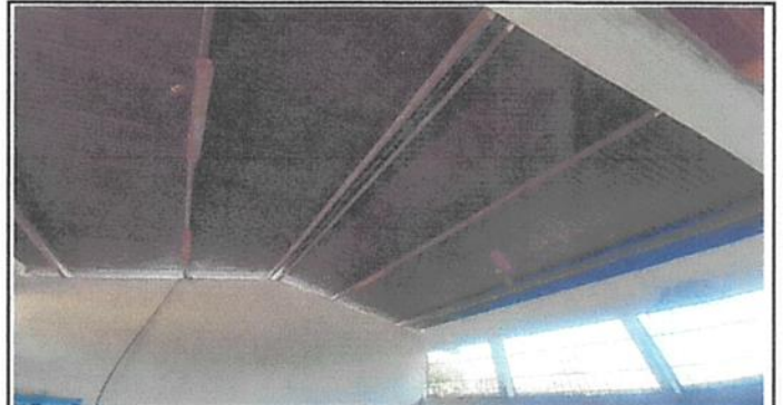
Foto 4: Reparación de sistema electrico, sustitución de lamparas
