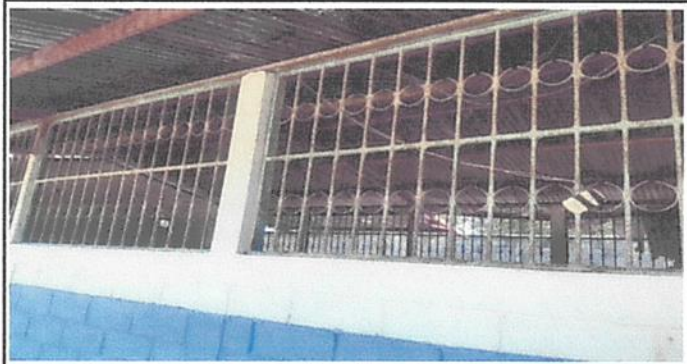
Foto 3: Mantenimiento a estructura de metal de ventana
