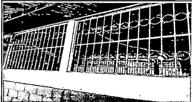
Foto 3: Mantenimiento a estructura de metal de ventana
