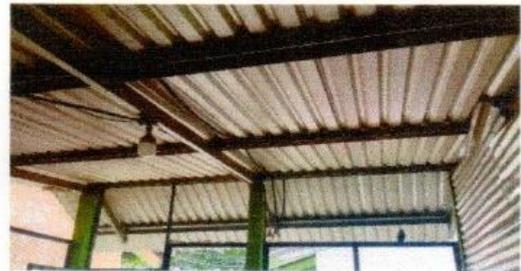
Foto 4: sustitución de estructura de madera por metal
