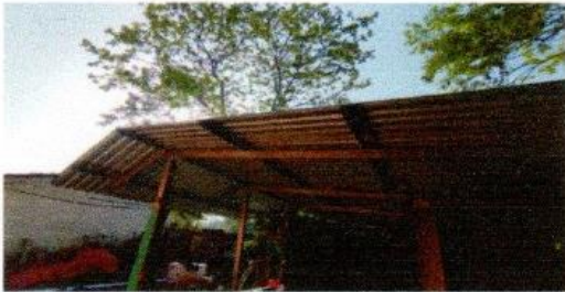
Foto 5: En proceso sustitución de lámina por lámina troquelada
