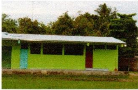
Foto1: En proceso sustitución de lámina por lámina troquelada
