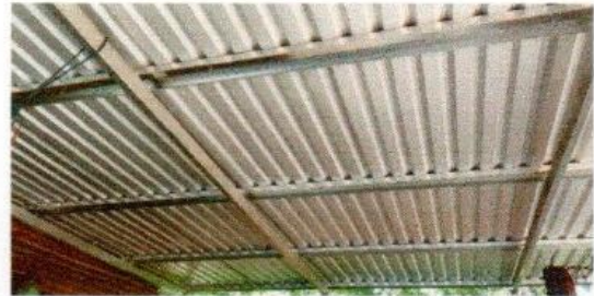
Foto 4: E proceso sustitución de estructura de madera por metal
