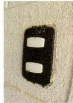
Foto 4: Sustitución de interruptores dobles
