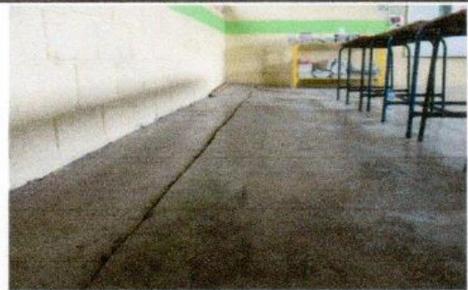
Foto 6: Sustitución de piso de torta de concreto
