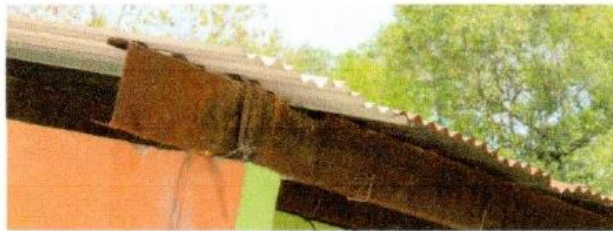
Foto 3: Sustitución de estructura de metal por metal
