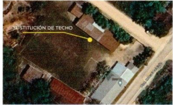
Foto 2: Sustitución de lámina por lámina por lámina troquelada
