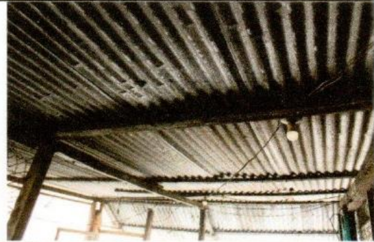
Foto 4: Sustitución de estructura de madera por metal
