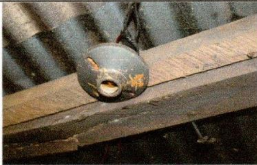
Foto 5: Sustitución de plafoneras
