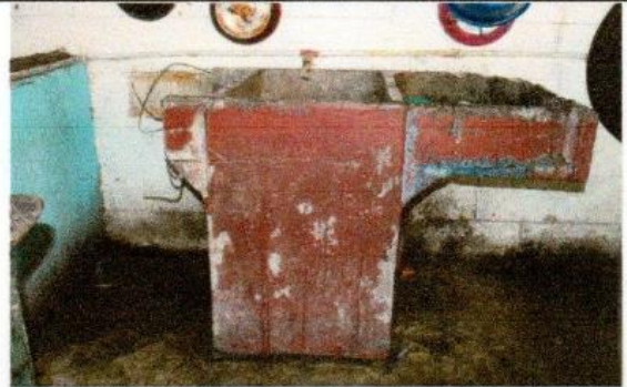
Foto 2: Sustitución de pila de cemento de dos lavaderos
