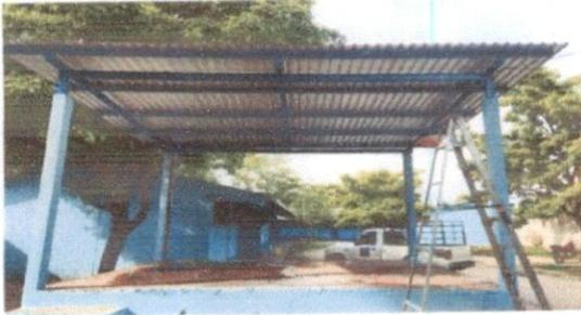
Sustitución de lámina, por lamina troquelada de aluzinc calibre 26.
